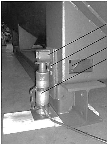
Рис. 3: Подъем котла с помощью подъемного приспособления (изображение для одной опоры котла)
