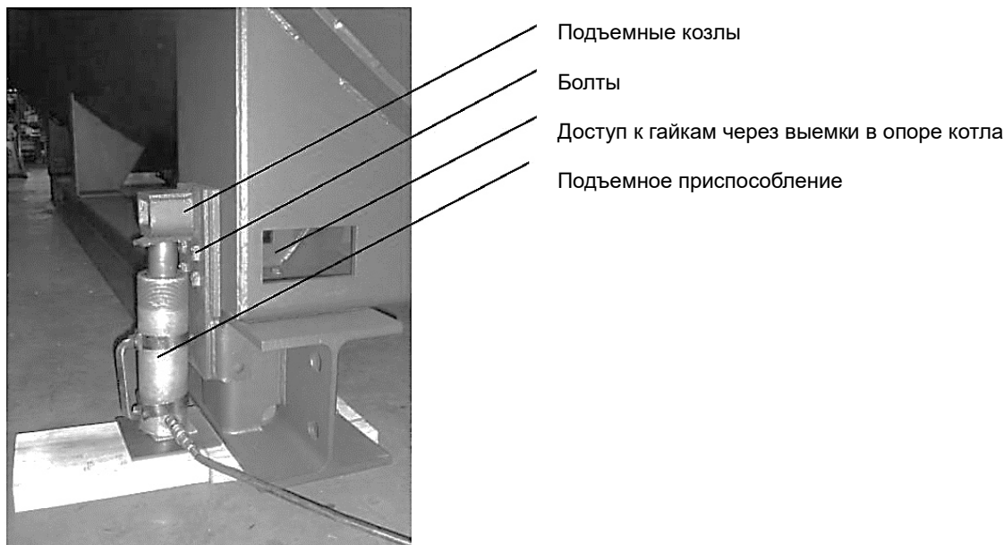
Рис. 3: Подъем котла с помощью подъемного приспособления (изображение для одной опоры котла)
